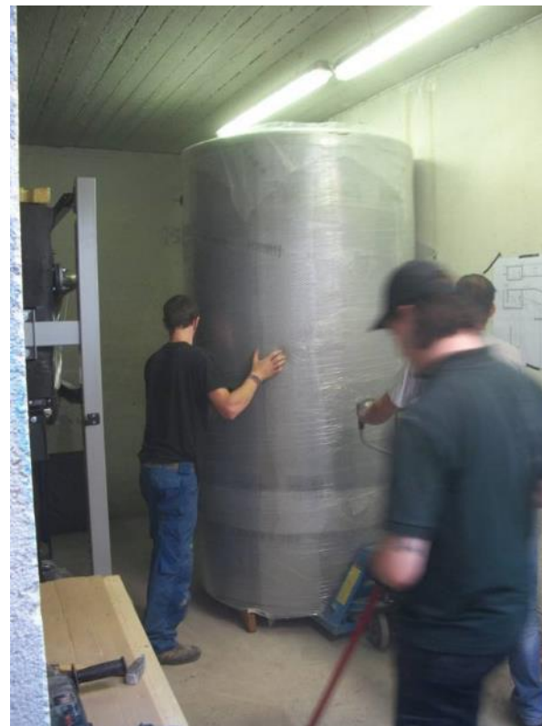
Montage Pufferspeicher
