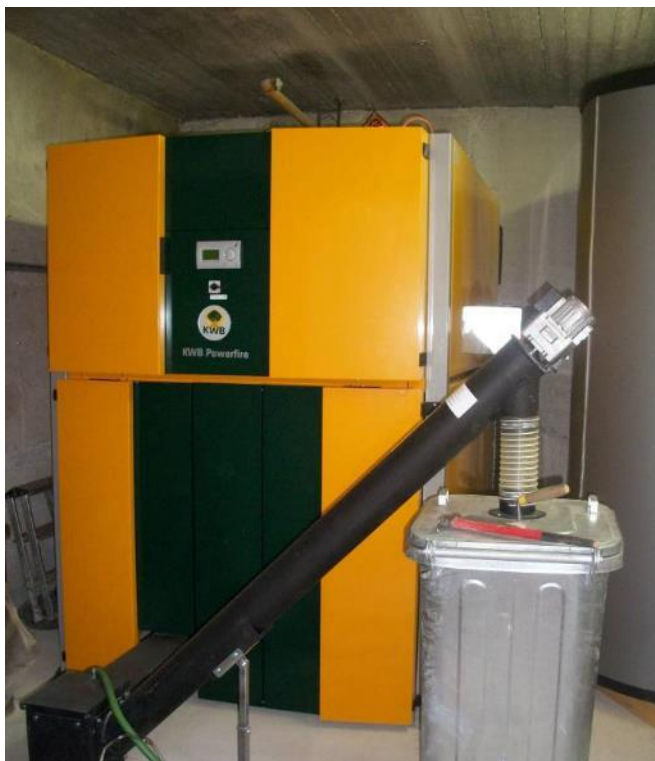
Biomasse - Heizkessel KWB POWERFIRE TDS 300 kW
