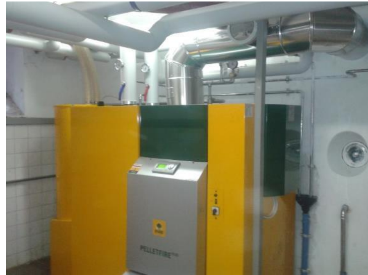
Pellets-Kessel 135 kW
