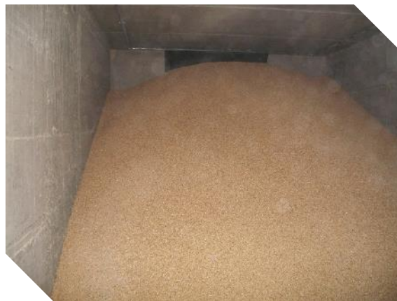
Deposito pellet 46 mc nel vano cisterna esistente
