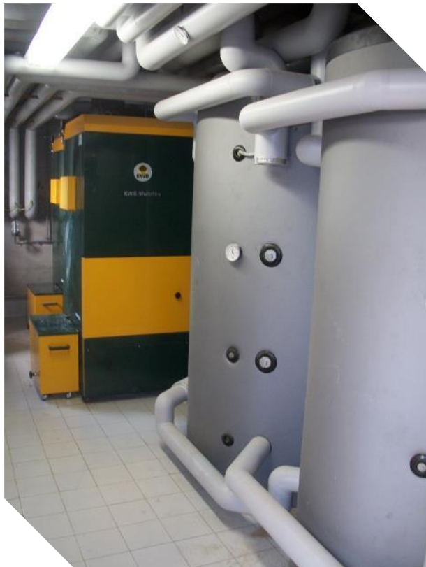
2 caldaie a pellet a 100 kW 2 accumulatori di calore a 2.500 litri
