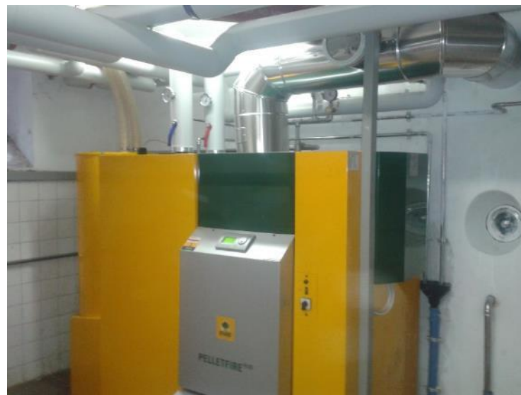
Caldaia a pellet 135 kW
