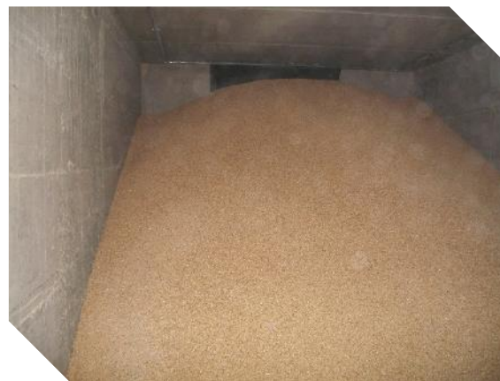
Deposito pellet 46 mc nel vano cisterna esistente
