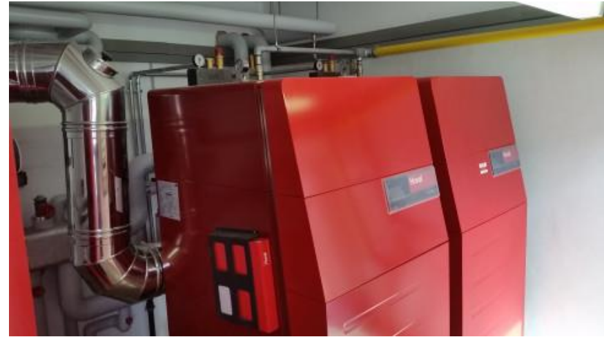
Impianto a gas condensazione HOVAL 250 D da 250 kW
