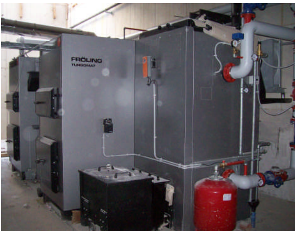
Biomasseheizkessel FRÖLING 2x320 kW
