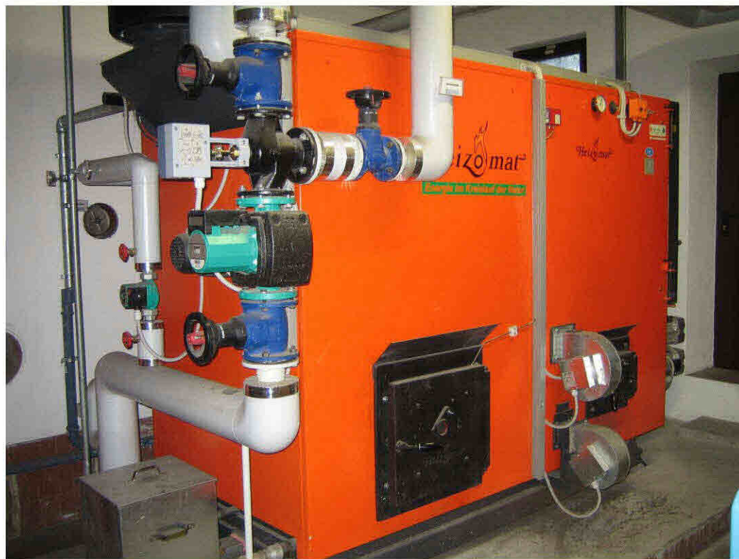
Caldaia a pellet 300 kW
