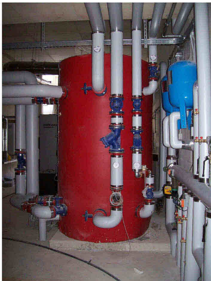
accumulatore di calore
